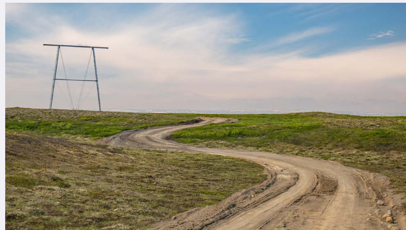
Dæmi 3. Nýleg línuslóð meðfram Hólasandslínu 3
