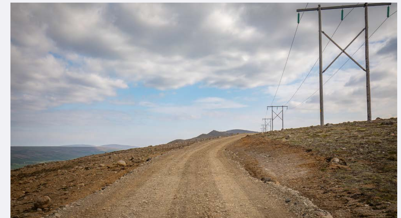
Dæmi 4. Nýleg línuslóð vegna Hólasandslínu 3
